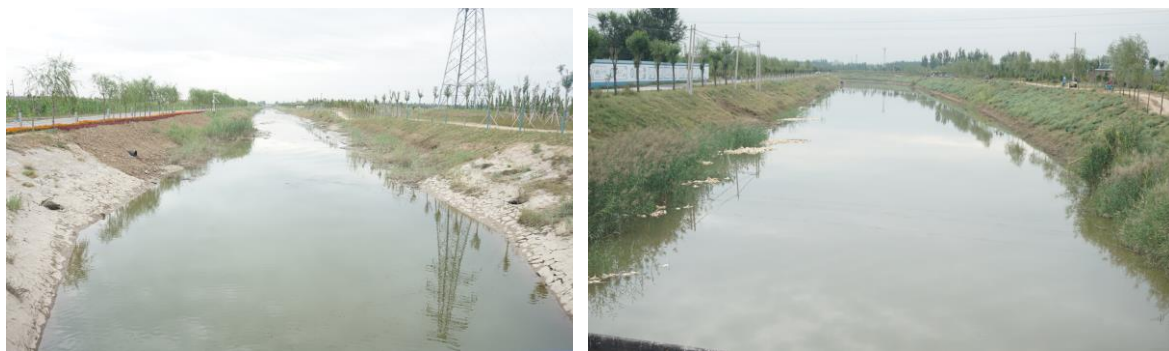
图 7.2-1 河道岸坡典型段
