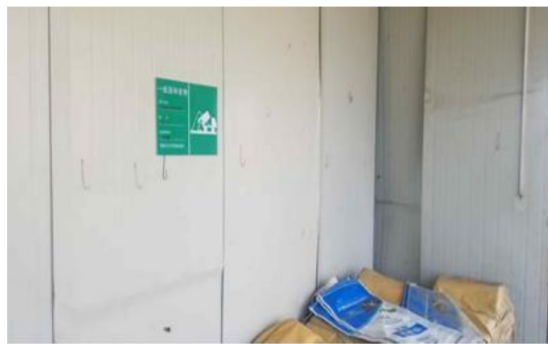
一般固废暂存间
