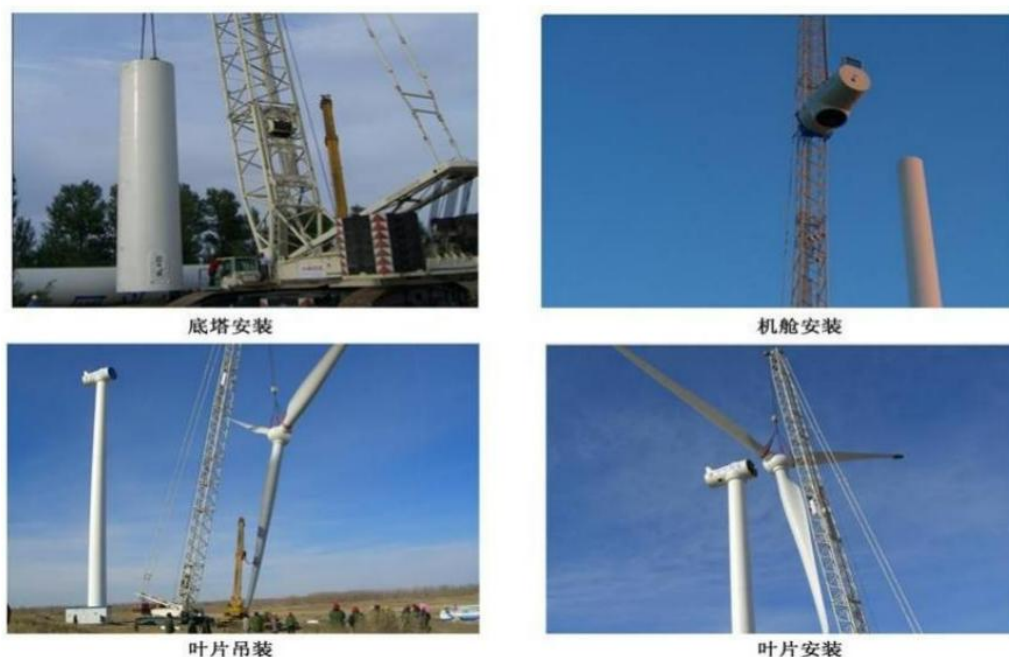
图 2-3 风力发电机组安装示意图
