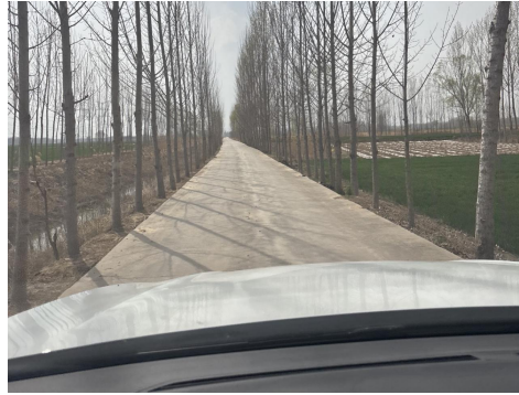
图 2-1 场内改扩建道路现场照片
