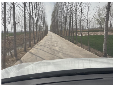
图 2-1 场内改扩建道路现场照片
