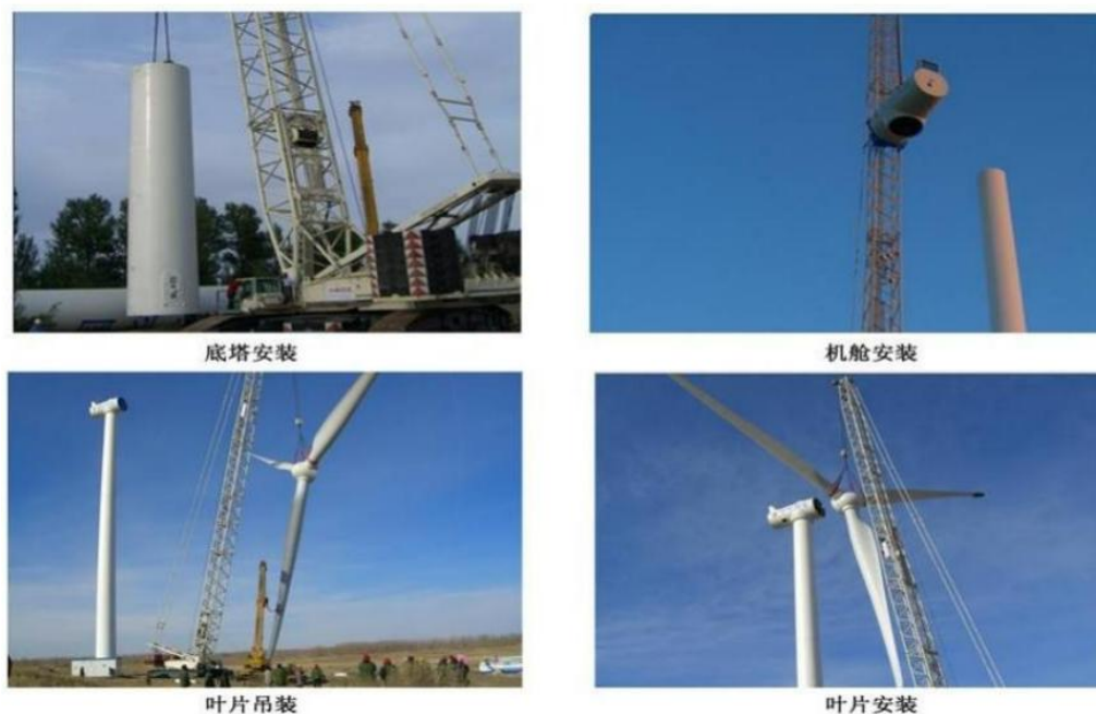
图 2-3 风力发电机组安装示意图
