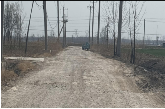
图 2-1 场内改扩建道路现场照片
